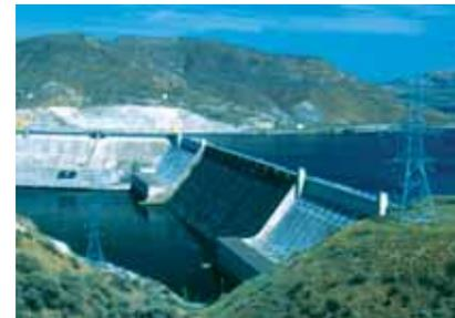
**Fotografía 5.4** Como se expuso en esta sección, la presa Grand Coulee soporta tres diferentes tipos de cargas distribuidas: los pesos de los elementos que la constituyen, las fuerzas de presión ejercidas por el agua sobre su cara sumergida y las fuerzas de presión ejercidas por el suelo sobre su base.
