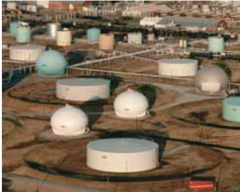
**Fotografía 5.2** Todos los tanques de almacenamiento que se muestran en la fotografía son cuerpos de revolución. Por tanto, las áreas de sus superficies y sus volúmenes pueden determinarse con los teoremas de Pappus-Guldinus.
